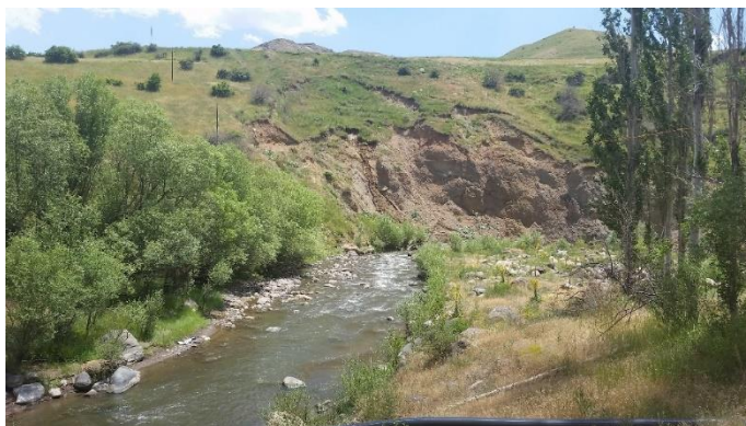
Рисунок 1. Оползневые процессы в долине р. Пирсаатчай
